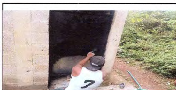
Foto 6: Reparacion de sanitarios
