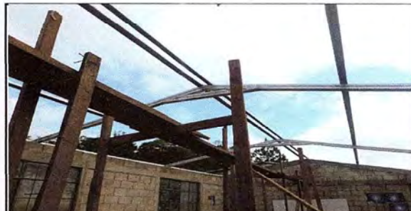
Foto 4: Aula 2. sustitucion de costanera y mantenimiento de puertas.
