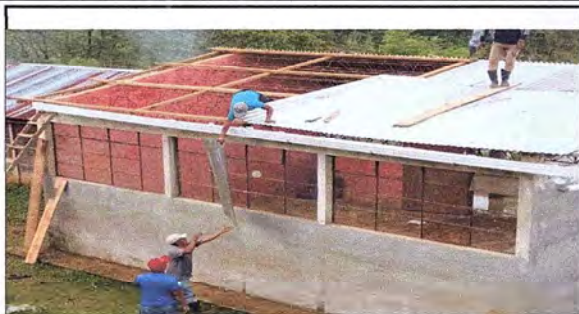
Foto1: Aula 1. Primero, Segundo, Tercero. Sustitucion de vidrios y estructura de techo
